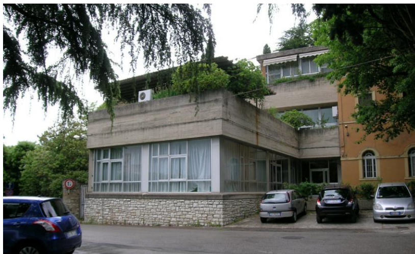
Vista dell'ampliamento in c.a. con tettoia da rimuovere
