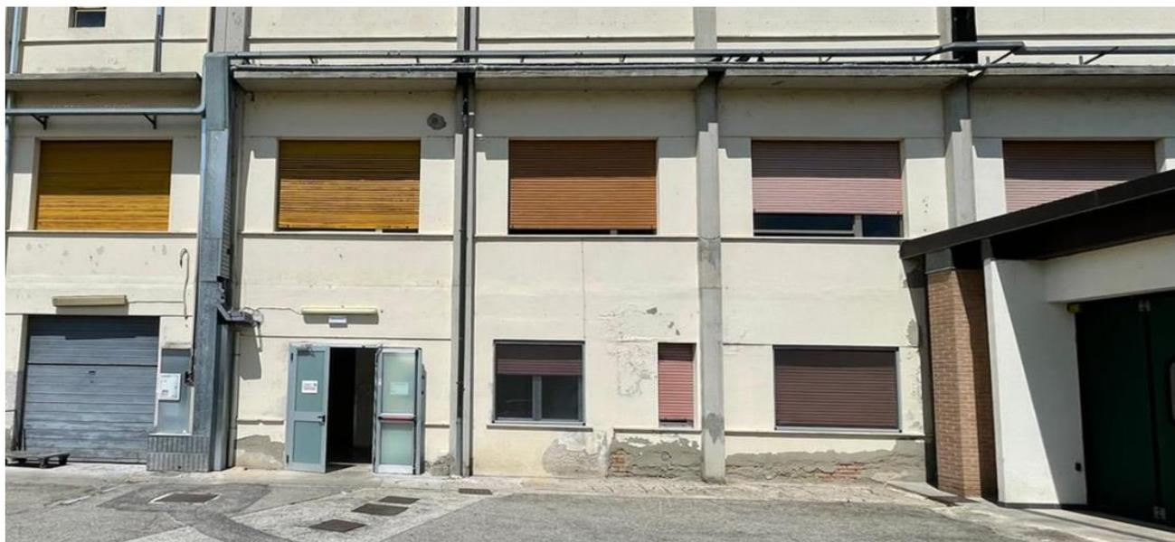
Sarà necessario, in caso di interferenze, adattare i pluviali alla presenza della passerella e viceversa, mantenendo la perfetta efficacia dei pluviali stessi.
