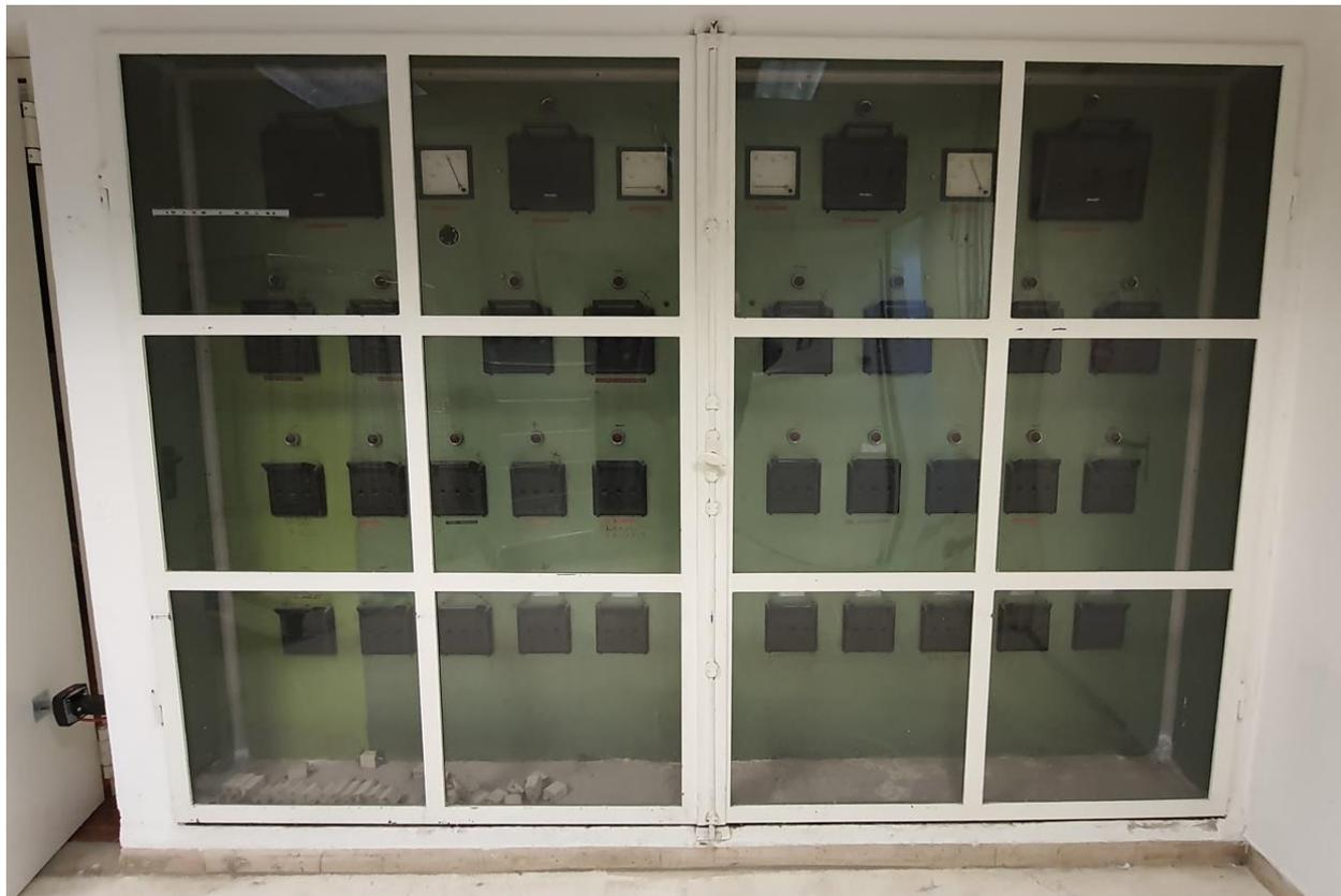
In fase di verifiche per la sua rimozione si è riscontrato che alcuni circuiti erano ancora utilizzati, non segnalati, ovvero parte del quadro era energizzata, detti circuiti alimentano la centrale termica, l'ascensore, le scale, il locale pompe e gli spogliatoi del sottotetto.
