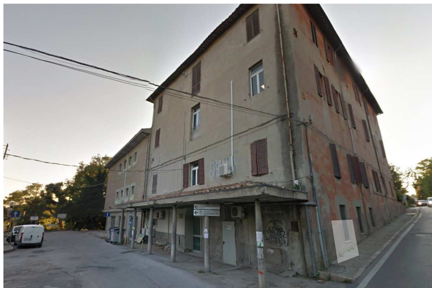
Vista dell'ingresso secondario al piano seminterrato dell'ex-padiglione Massari
