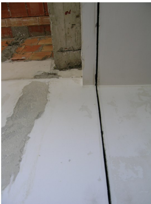
Foto 1 – Giunto sismico esistente (2 cm)
