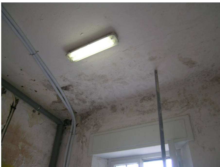
Foto 4 – Infiltrazioni di acqua al Piano primo
