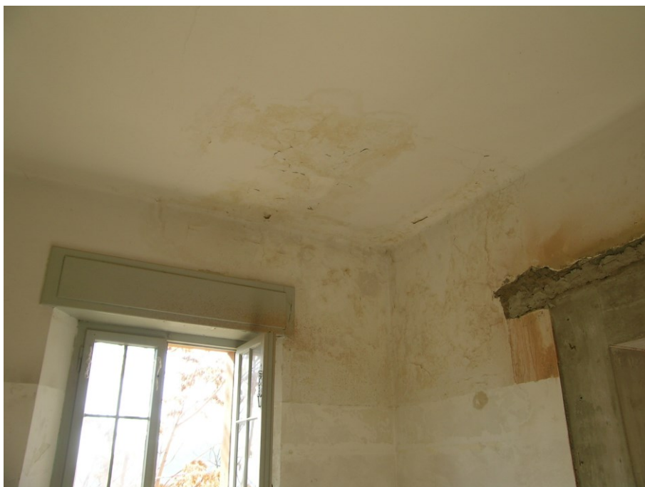
Foto 3 – Infiltrazioni di acqua al Piano primo
