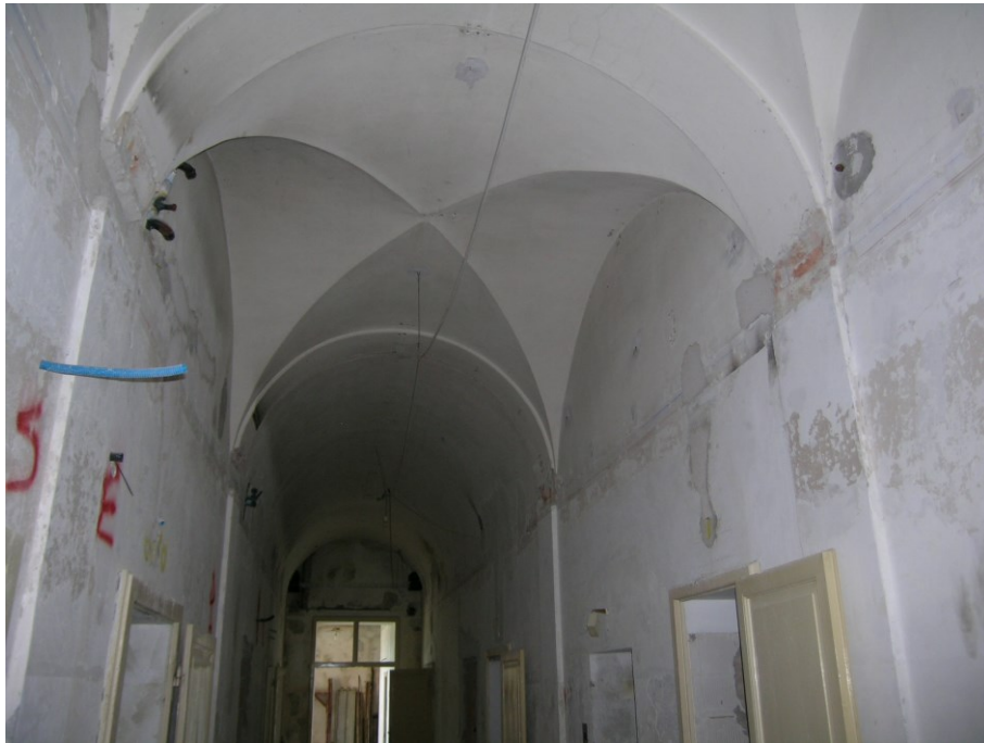
Foto 2 – Volte a botte e a crociera rinvenute al Piano terra durante i lavori
