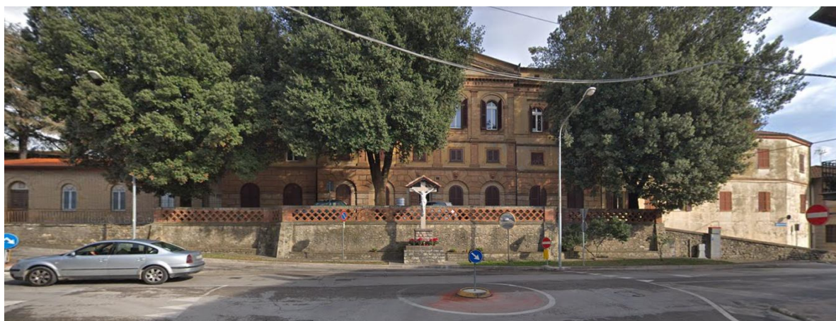
Vista da via G. Latterini
