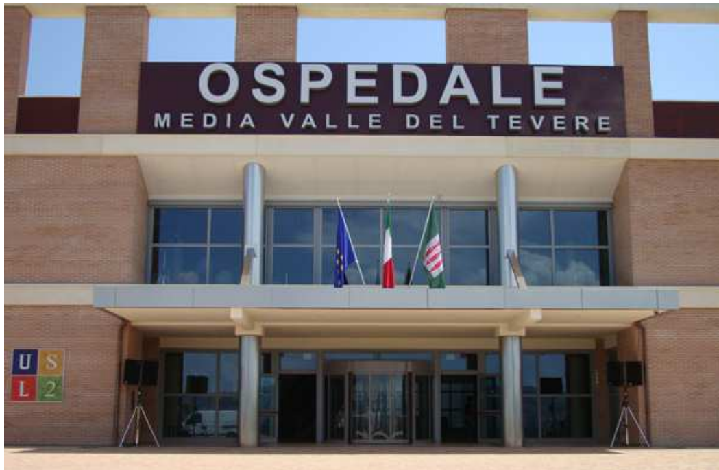
UOS Diagnostica per Immagini MVT: Blocco Centrale (E) – 1° Piano
